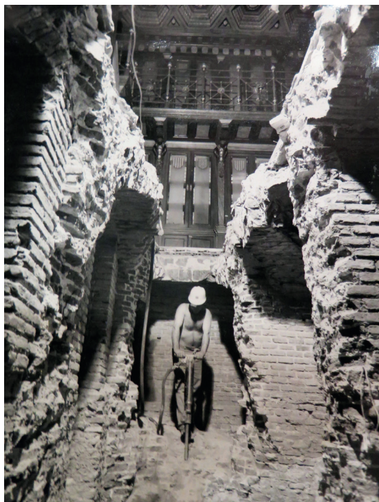
(Fig. 33) Demolición de la primitiva cimentación de bóveda bajo uno de los Gabinetes de Lectura, para la construcción de un nuevo sótano 62 .
