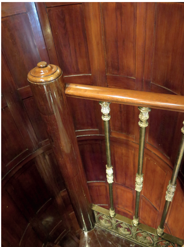
(Fig. 7) Interior y balastrada de remate de la escalera de caracol.
